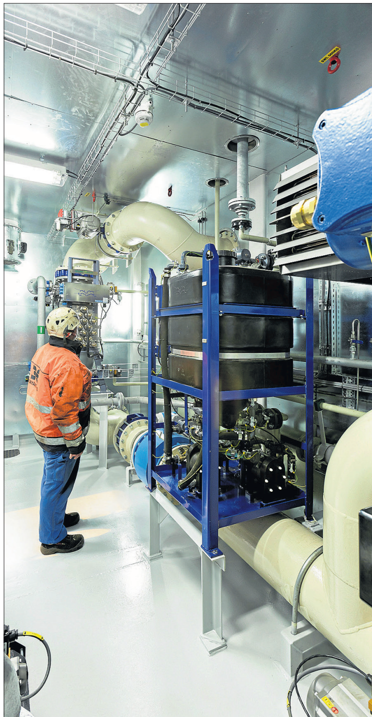
Et blik inde fra containeren, hvor det færdige ballastvandsrensningsanlæg er installeret og klar til at blive sat i drift. Foto: Fayard
